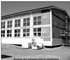
Budowa sali gimnastycznej w Justynowie
