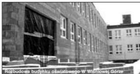
Rozbudowa budynku oświatowego w Wiśniowej Górze
